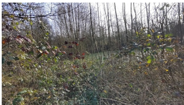
Au-delà du pont, le Moulin est envahi par la végétation.
